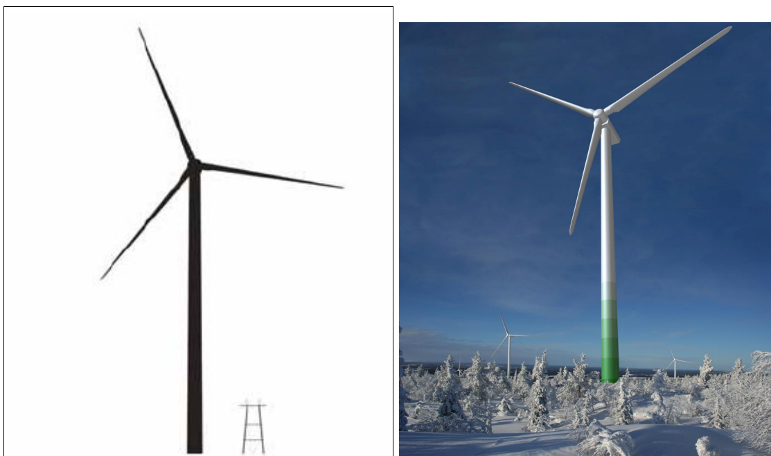
Bild 3. Vänster: Vindkraftverk (höjd ca 150 m) och kraftledningsstolpe (höjd ca 20 m) i samma skala. Höger: Illustration, bildmontage, bergsryggen på Mielmukkavaara, färgalternativ grönt. Källa: MKB-beskrivning, Pöyry Management Consulting Oy, 2010.
