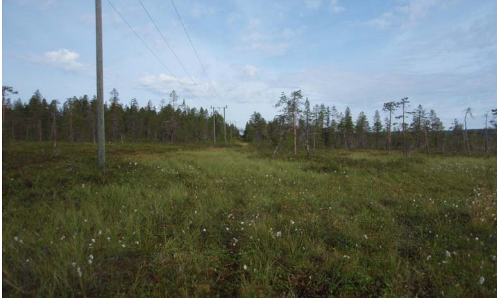
Kuva 1-4. Olemassa oleva johtolinja Kannonmaan eteläpuolella. (Kuva: Kilpeläinen/Pöyry)
