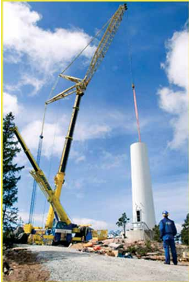
Kuva 4.5 Tuulivoimalan pystytys Högsärassa, Turun saaristossa (kuva: Havator Oy).
